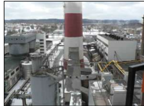
2-oji Vilniaus termofikacinė elektrinė
